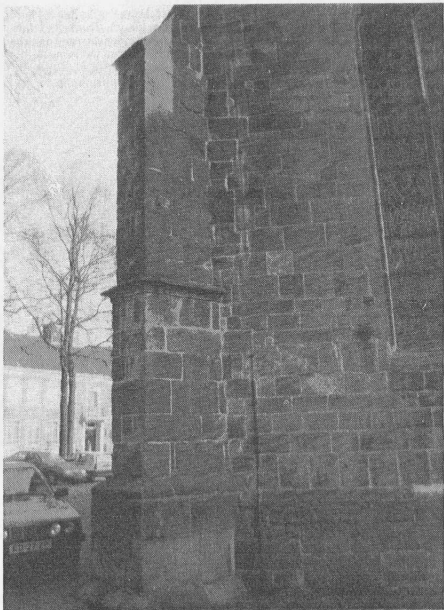
Een deel van het nieuwe contrafort.
