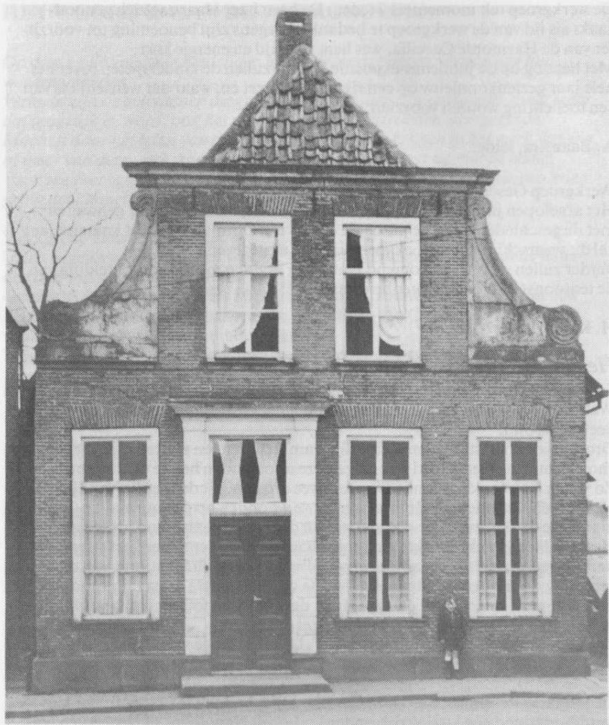
"De woning aan de Walstraat hoek Keerweer vóór de restauratie van 1965"
