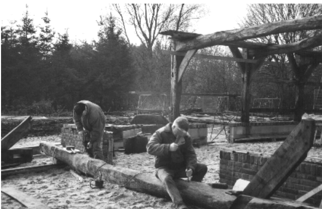
Ton Jansen (links) en Henk Geerdink bewerken een stuk gebint voor de schaapskooi.
