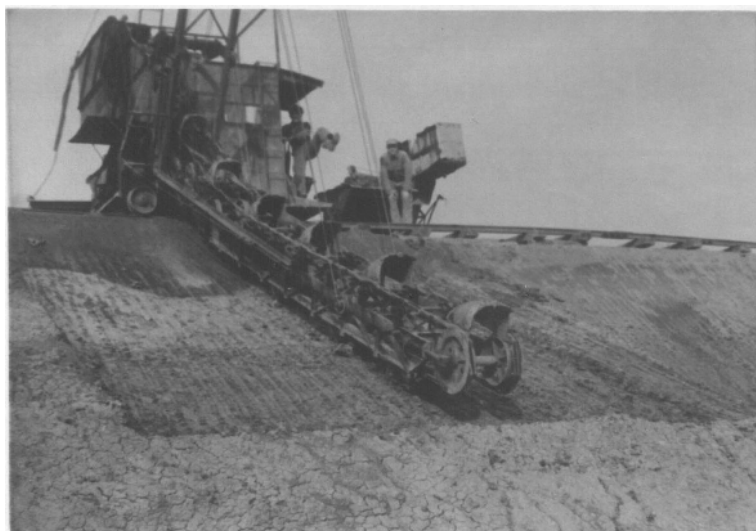
De machine rechts is voor het afgraven van de klei De linker machine is voor het afgraven van het leem. Deze leem werd vermengd met de klei..
