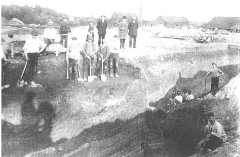
Het was letterlijk en figuurlijk handwerk om de grondstof – de zeeklei – uit de grond te halen. Op de achtergrond de steenfabriek en de man met de bolhoed is de heer J.H.B. Scholten eigenaar van de steenfabriek.
