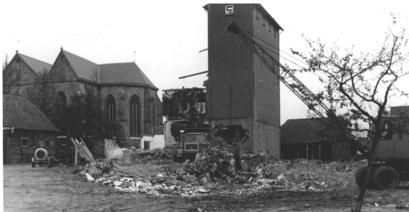
De afbraak van het CAVV gebouw aan het Kerkplein.
