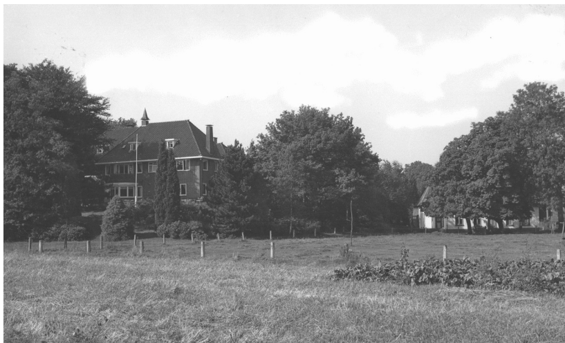
De villa van Hagedoorn met rechts de limonadefabriek.
