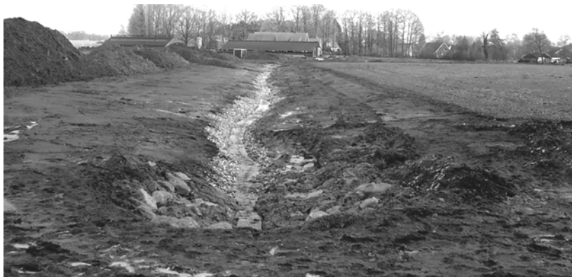
Aanleg van de nieuwe beekbedding van de Kropsbeek
