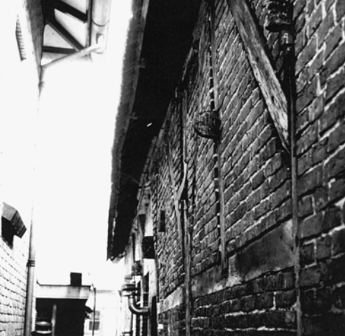
Zijgevel met gebintwerk van pand Rikmanspoel Foto RACM (Zeist)
