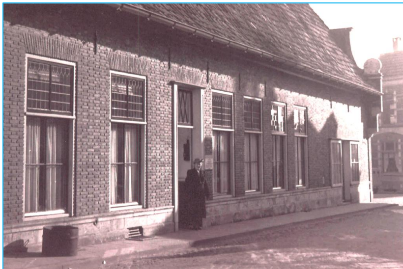
Mevr. Essink-van Stralen voor het geheel verbouwde pand. 1949
