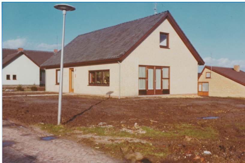
De Stobbenkamp in aanbouw, Foto 1970
