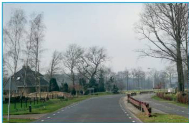
2014 Deel van de Dusinksweg met vrijliggend fietspad.
