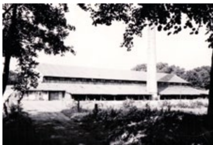
Nieuwe overkapping steenfabriek
