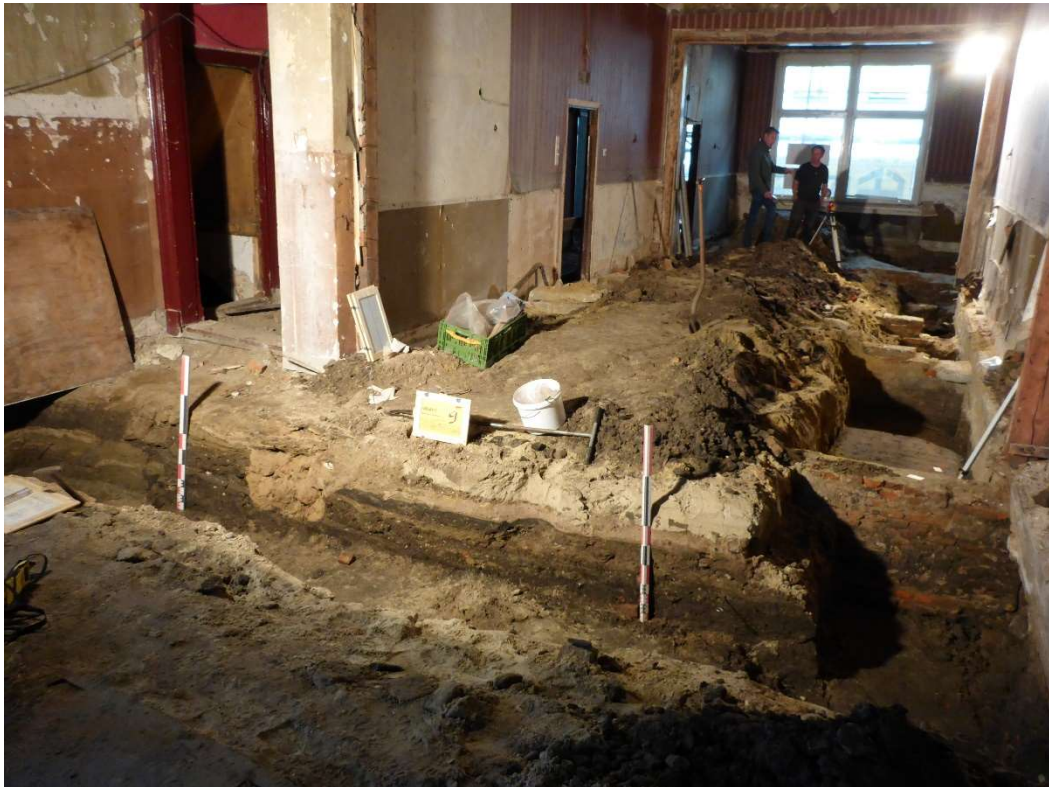
Afbeelding 6. Overzicht van de voormalige zalen 1 en 2 in Hotel La Poste, oostwaarts gezien richting Marktstraat met rechts werkput 1 en 2 en op de voorgrond werkput 3 met profiel 4. Werkput 4 is later aangelegd ter hoogte van de deur in het midden van de foto.
