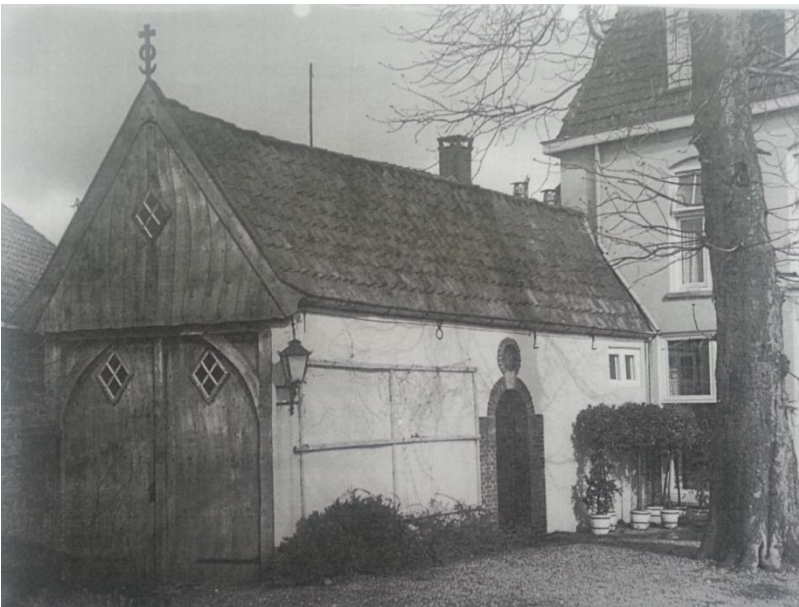
Het koetshuis na de restauratie
