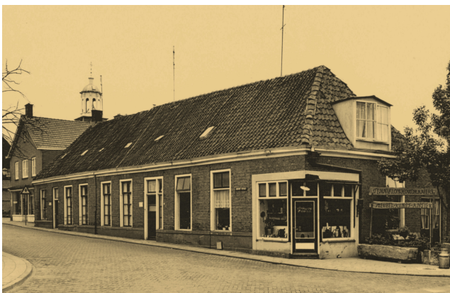
Het pand voor de grote restauratie.
