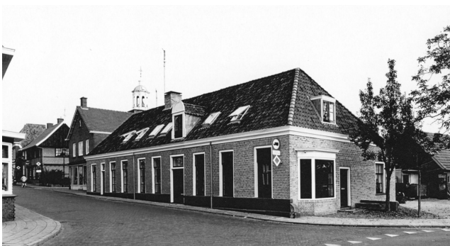
Het pand na de grote restauratie.
