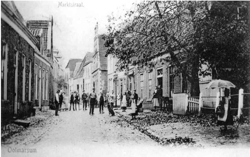
Een foto uit 1903 van de Marktstraat. Aan de rechterkant de voormalige herberg de "koppelpaarden" ( in 1914 afgebroken door A. Kip), daarnaast het pand Muurlink met vóór het pand de heer Jacobus Hendricus Muurlink.
